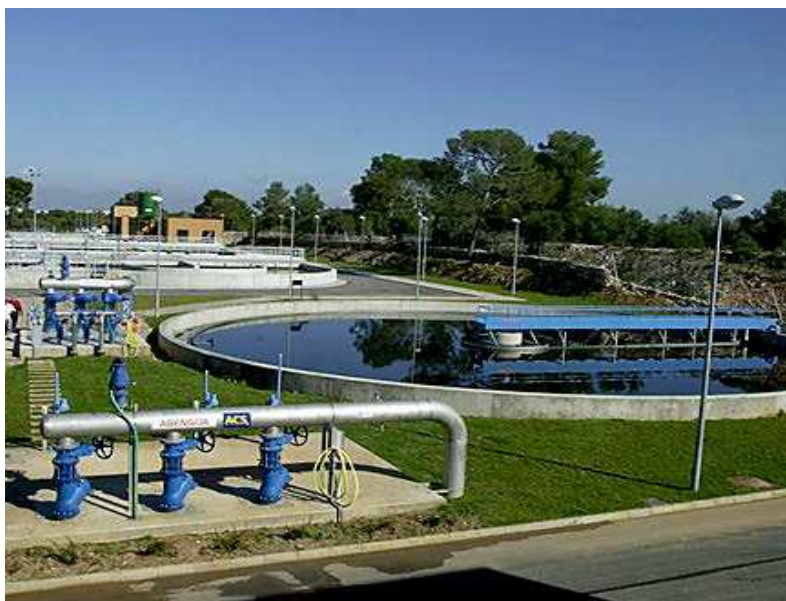
El Gobierno financiará la ampliación de varias estaciones depuradoras. EFE
